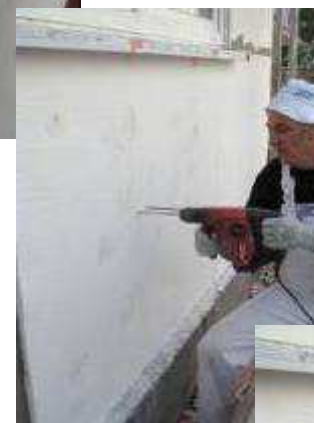
2. Przewiercenie we wcześniej wykonanym otworze
