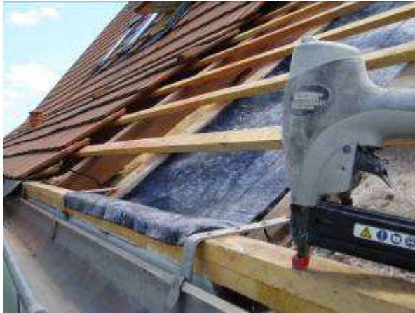
Montaż za pomocą zszywek
