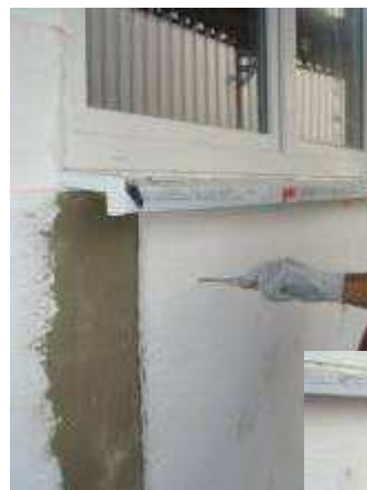
1. Wykonanie otworu w izolacji
