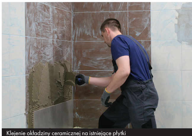
Klejenie okładziny ceramicznej na istniejące płytki
