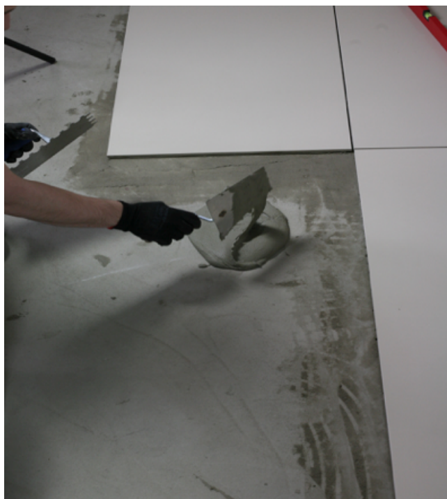
Zwiększona retencja wody w zaprawie CM 22 umożliwia dobranie odpowiedniej konsystencji w zależności od zastosowania
