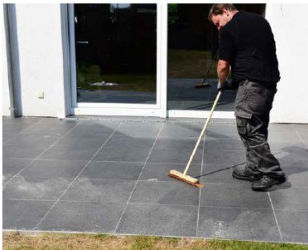
16 ... a resztki zaprawy zmieść.
