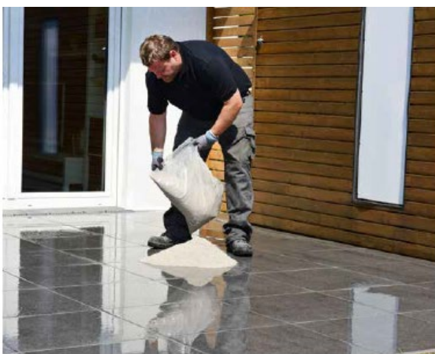
11 Fugę Sopro Solitär® F20 wyłożyć na okładzinę.
