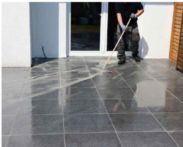
15 Nadmiar zaprawy fugowej usunąć ...
